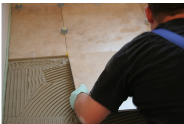
Schritt 3: Einlegen der Fliese ins Kleberbett
